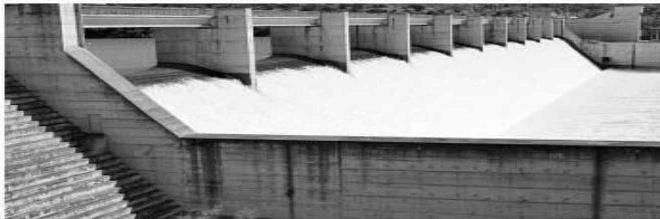
La presa de Pedrógão.
